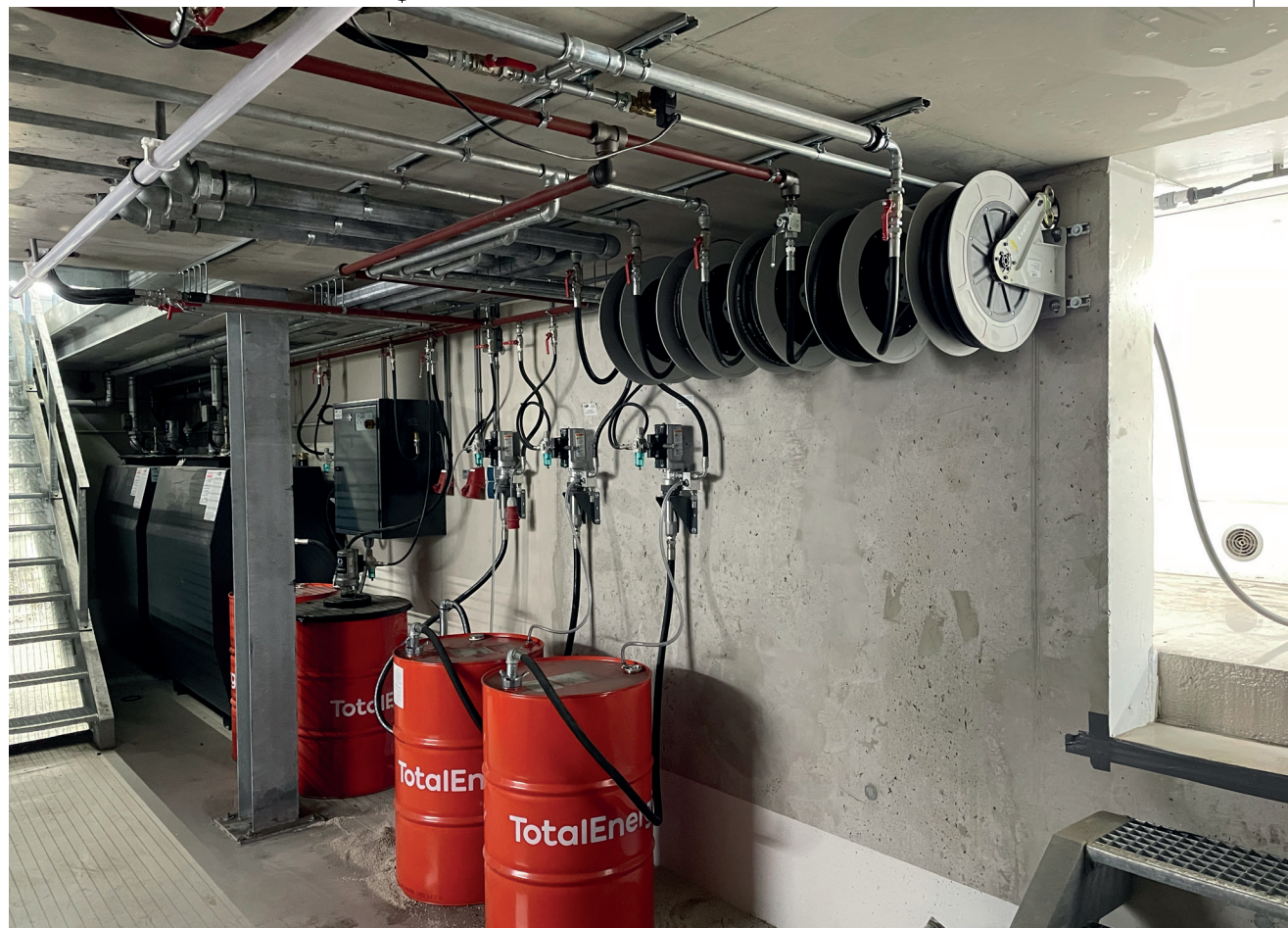
haspels een plek kregen zodat deze niet in de put zelf hoeven te hangen. Putkrikken en een oliebak maken de put zelf verder af.
