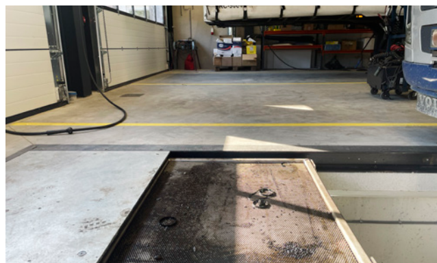
De olie-opvanglade rolt in de rails bovenaan de put en verdwijnt na gebruik uit het zicht.
